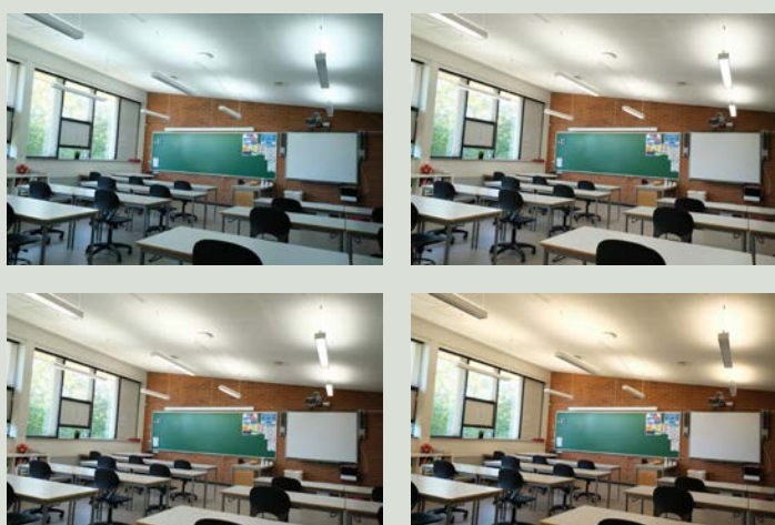
Figur 1. De fire lysscenarier: øverst til venstre "chrome" og til højre "elevarbejde". Nederst til venstre "fælles" og "hygge" til højre. Tilsted Skole, klasseværelse mod vest. Foto: KHR.
