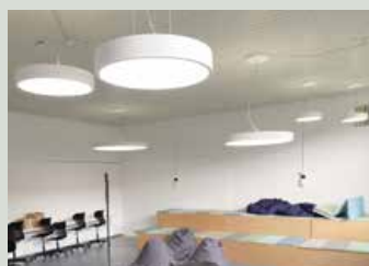
Fællesrum på Hanstholm Skole før (april 2019) og efter (september 2019) installation af nyt LED-lys med separat indstilling af lysintensitet og lysfarve for både uplight og downlight
