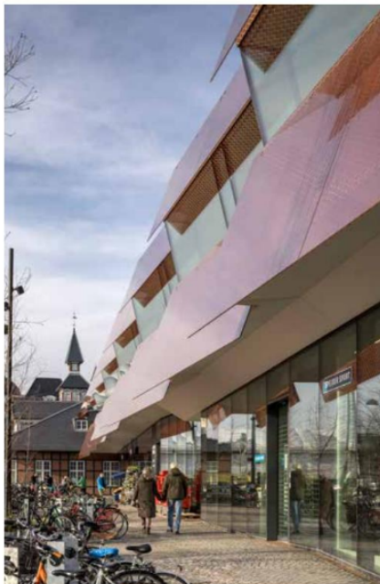
Facaden på Østerport. Foto: Adam Mørk for KHR Architecture
